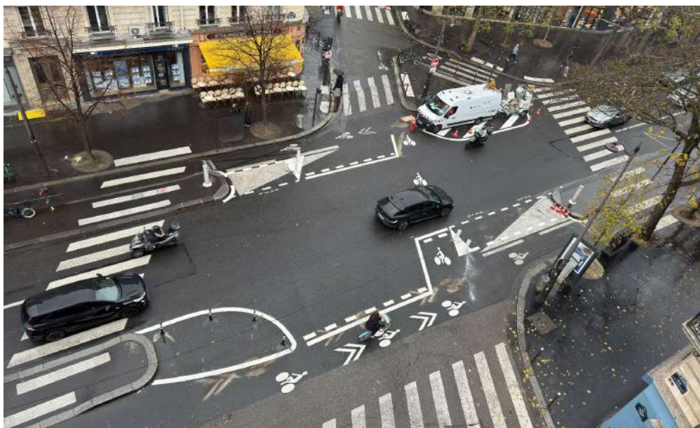
Le carrefour boulevard Voltaire/rue de Malte est l'un des carrefours dangereux aménagés en 2025.
