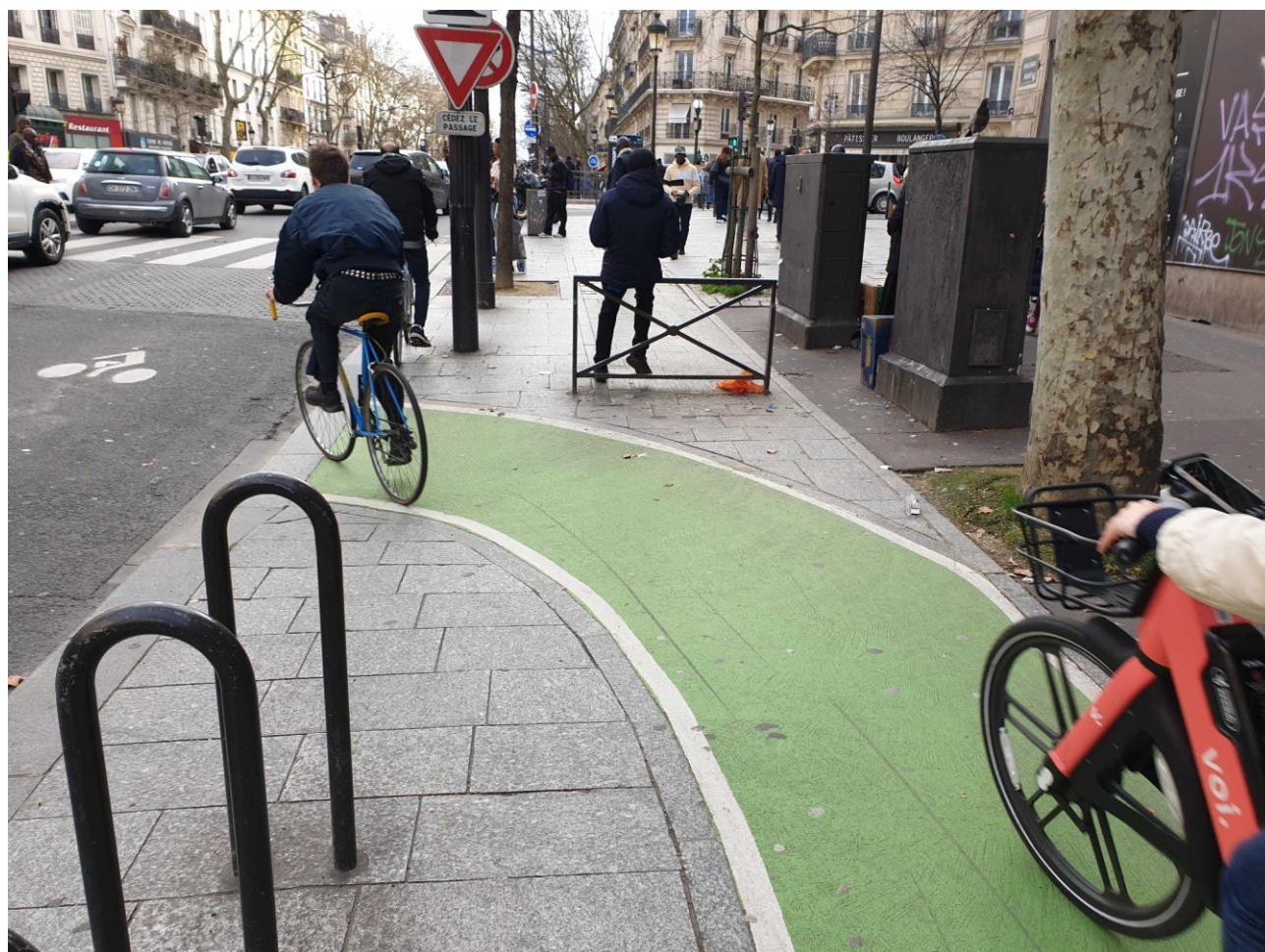
Vue boulevard Barbès ouest avec rupture de la piste et renvoi abrupt vers la voie bus.
